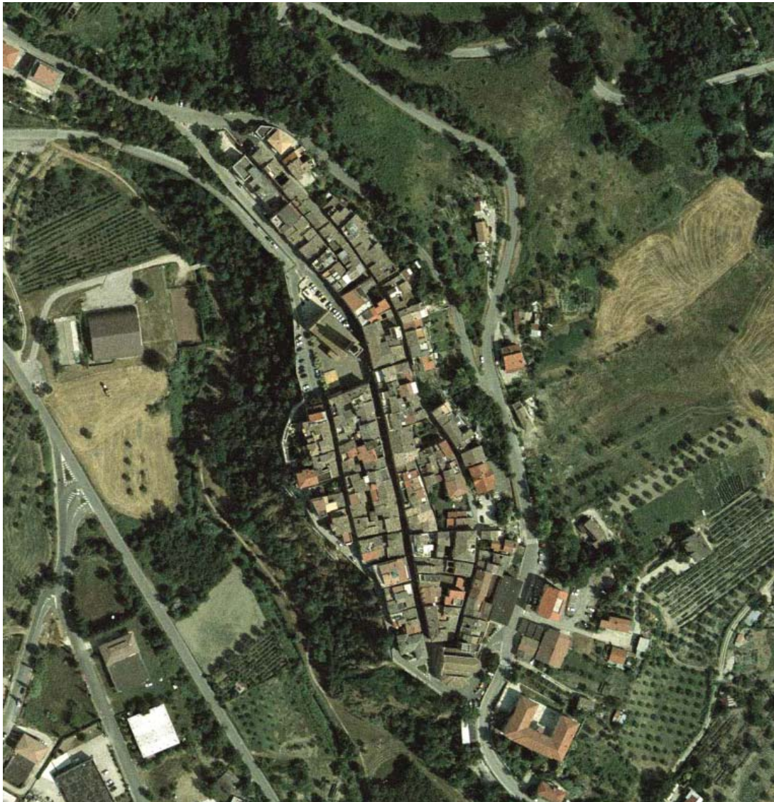
Figura n. 1. Il caso studio: il centro storico di Appignano del Tronto, foto aerea, 1998.
