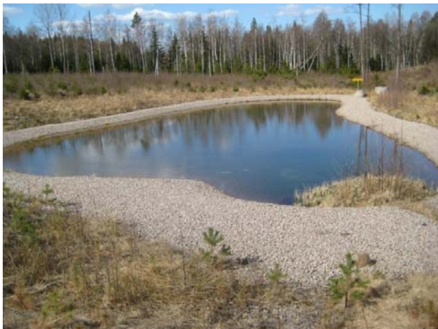
Figur 9. Sedimentationsdamm Sävsjö [16]
