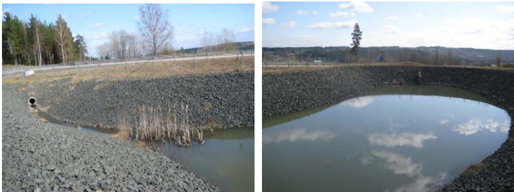
Figur 15. In- och utlopp, stora sedimentationsdammen Aneby [16]
